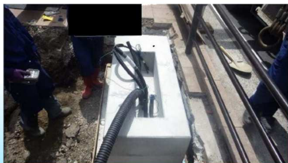
現場での設置状況
