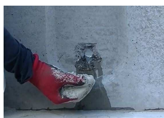
①ボトルから「即トメーる(粉体)」を手に取り、漏水箇所へ。
