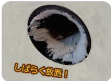
3:全体表面にテカリが生じたら、ピカリスターがとめ太郎に十分馴染む様、しばらく放置する事。 ※(推奨)放置時間:15~20分間。放置時間を長く確保して頂くことにより、除去/剥離作業を容易に、進めることが可能です。
