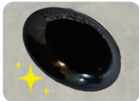
5:最後に軽く水拭きを行い、とめ太郎除去/剥離作業完了。 ■本ご施工手順は、とめ太郎除去/剥離作業限定となり、その他の対象物の手順は、経過期間・放置時間・下地等の個々条件によって異なります■
