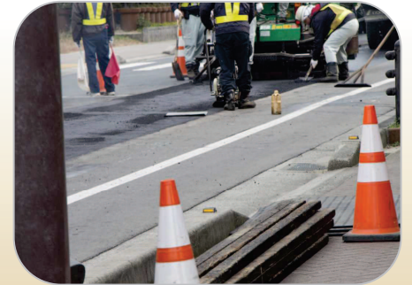
アスファルト汚れ 除去
