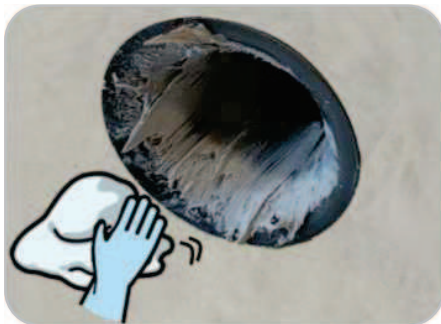
1:管路口からケーブルを撤去、その後必ず作業用手袋を着用の上、奥側のバックアップ材、更にとめ太郎を取り除いてください。
