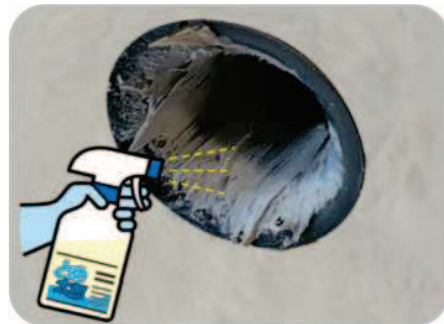
2:ピカリスターを、スプレーボトルより、直接管路口(管路凹部/バルマウス表面)のとめ太郎に、隅々までタツプリの吹きかけます。
