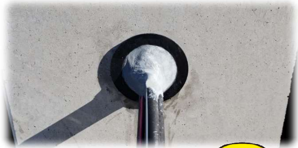
⑧CVTケーブルの場合、仕上げに撚り中央部を指先で念入りに充填し、充填作業完了。
