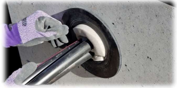
②ケーブル伝いに管路口奥側へ押込む。
